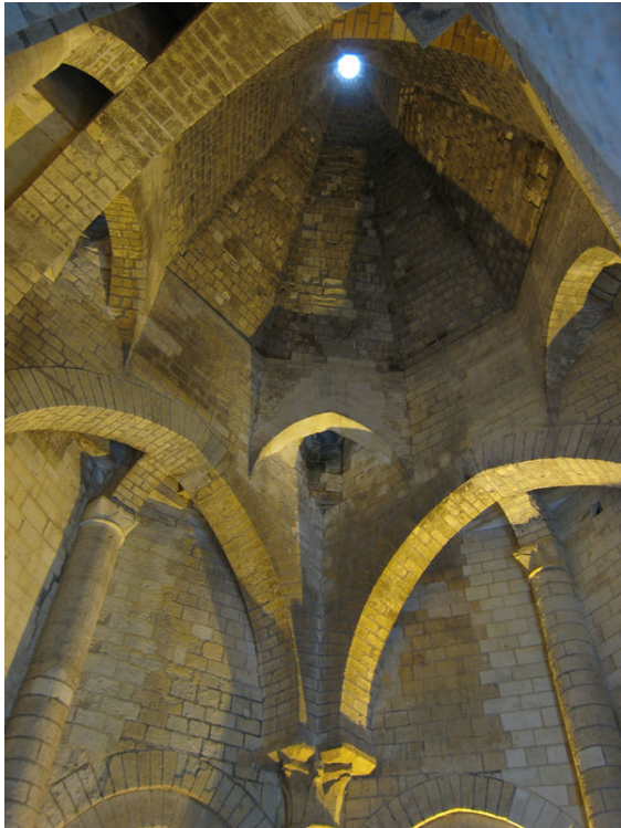
Schornsteindurchlässe in der Kuppel der Küche; das unterste Kapitell hat die Form einer Krone
